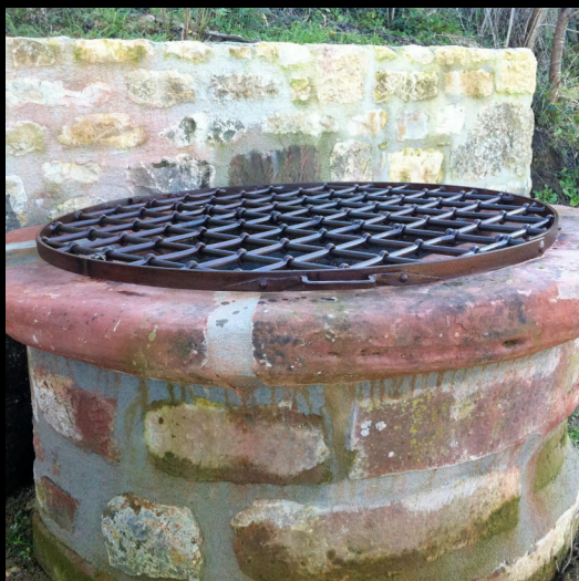
PROTECTION DE PUITS
